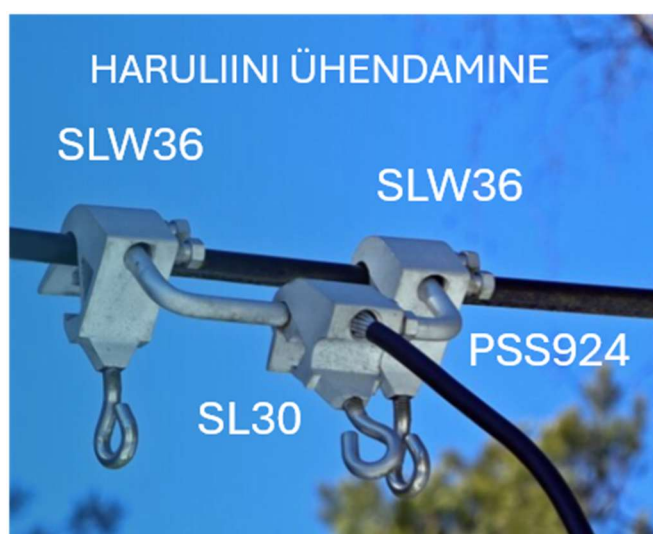
Joonis 3.1. Haruliinide ühendamine mastidel 98H6, 111 ja 123.
